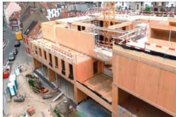
3 | Application du Cross Laminated Timber dans une école maternelle
